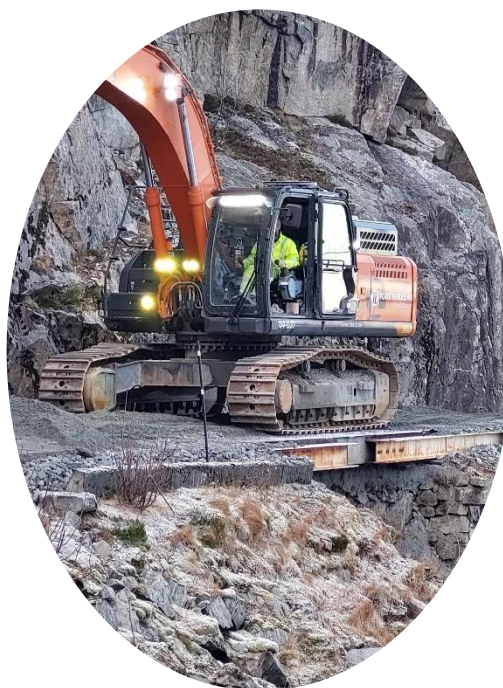
Arbeid med Setransveien
