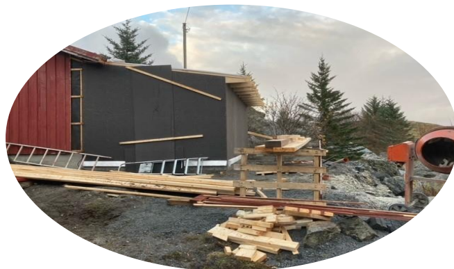
Vannverket på Skjervøya
