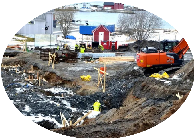
Fra byggeplass, Flerbrukshus, ved skolen
