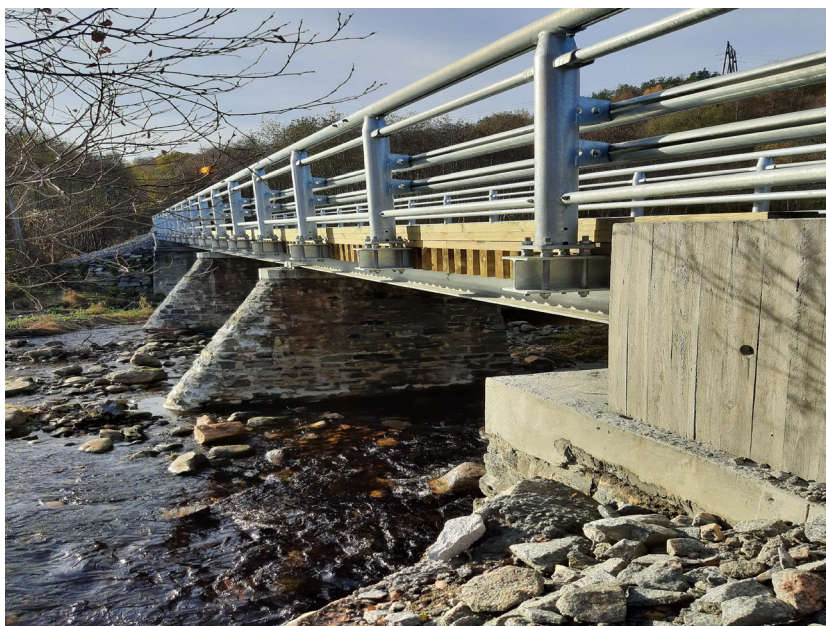
Hoksdal bru etter rehabilitering
