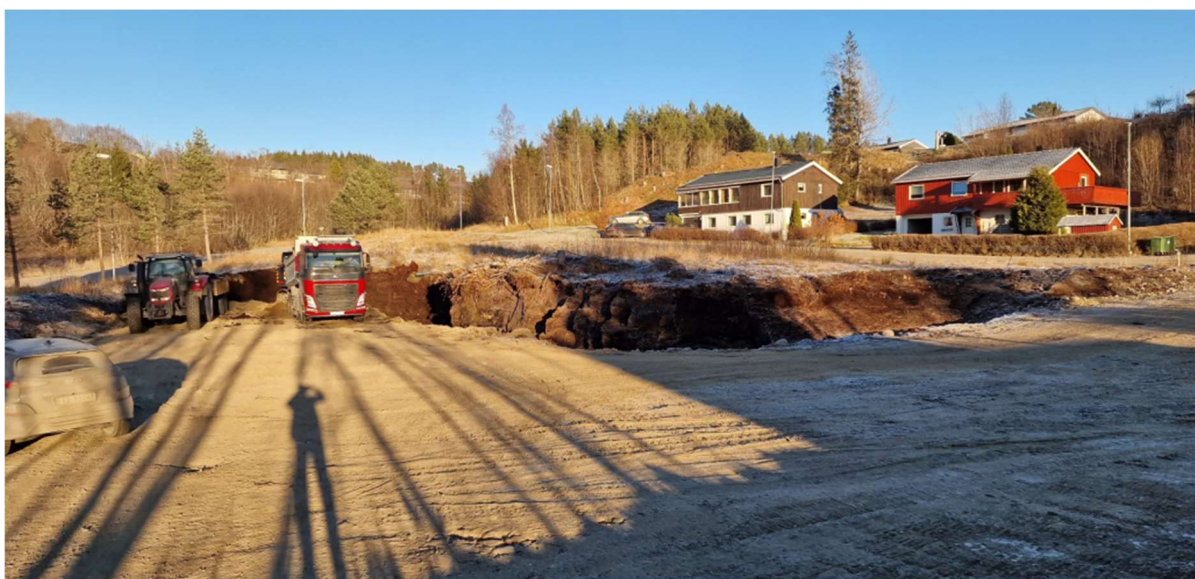
Boligutviklingsprosjekt Tørrstuveien - pågående masseutskifting
