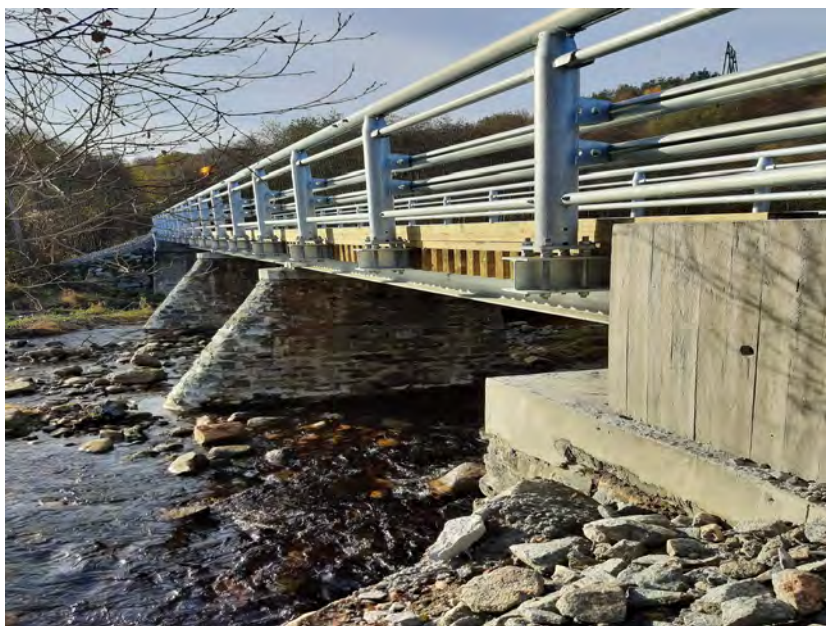
Hoksdal bru etter rehabilitering
