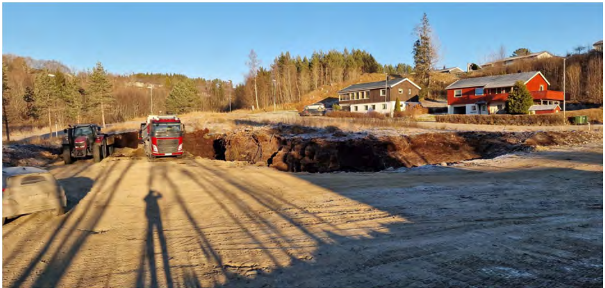
Boligutviklingsprosjekt Tørrstuveien - pågående masseutskifting
